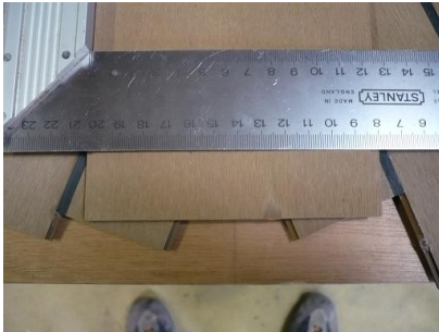
Centrage par rapport aux joints noirs des panneaux
