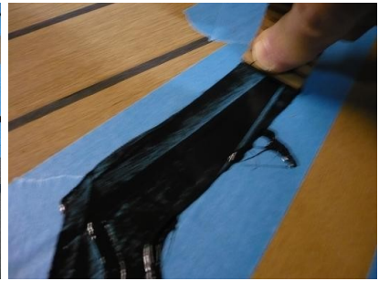
On tire le joint à la spatule
