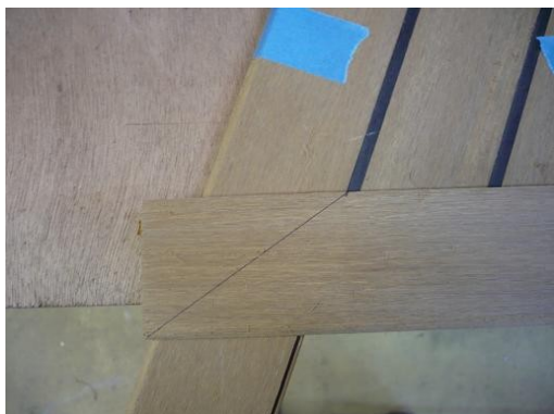
On trace l'intersection entre les 2 bordures
