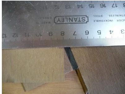
Marquage sur l'intersection avec le côté intérieur du joint noir
